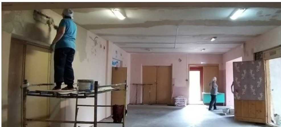
Ремонт СДК с.Зимогорье
