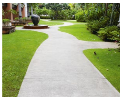
Бетонное монолитное покрытие
